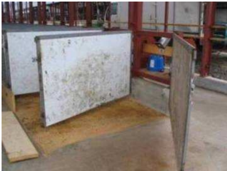
写真9 ペンの仕切りが折りたため、楽に除糞や洗浄、消毒ができるように工夫されている
