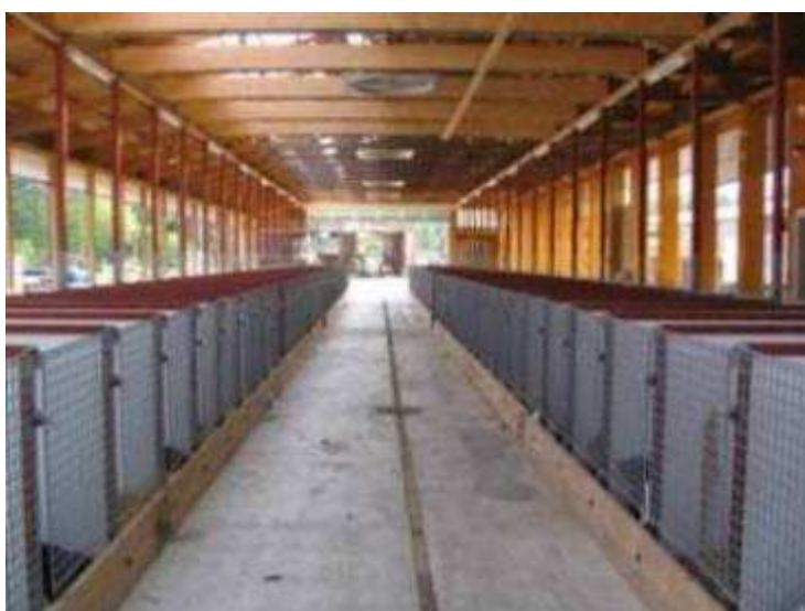
写真7 両サイドには巻き上げ式カーテン、天井にはプロペラで換気に配慮している
