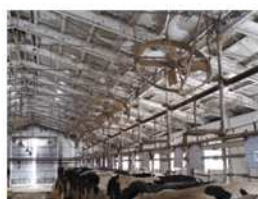
採光や換気扇の設置
