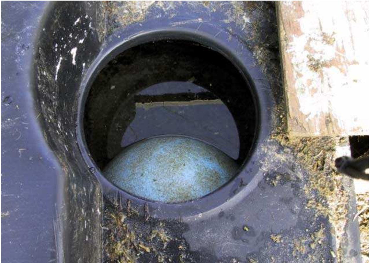
清掃が困難なホール式水槽
