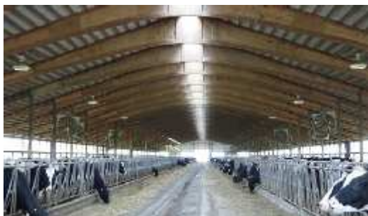
写真4：天井を高くし換気を良くした事例
