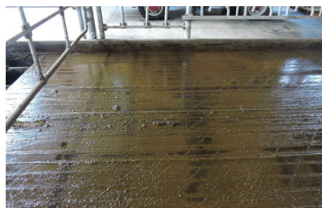
(写真1) 酪農試験場のフリーストール牛舎 元々あった溝に対して斜めの溝を追加施工
