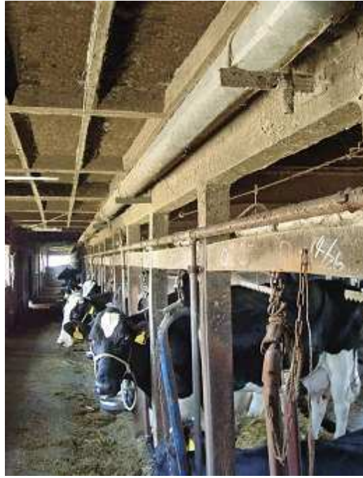
太い塩ビ管を配管した改造例(写真2)
