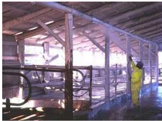
石灰乳塗布の様子
