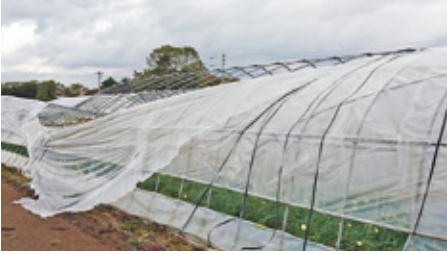
平成28年のハウス被害 突風によって骨材が潰れた
