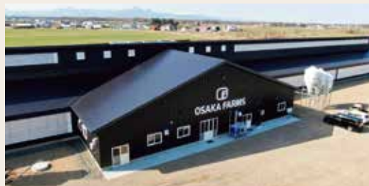
令和5年5月に完成したロボット牛舎
