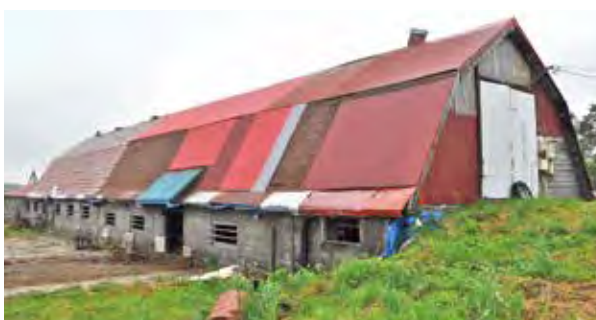
修繕した牛舎の屋根
