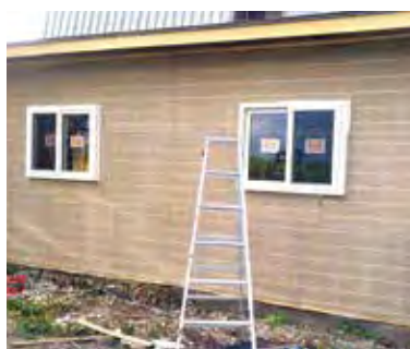
リフォーム中の自宅の外壁
