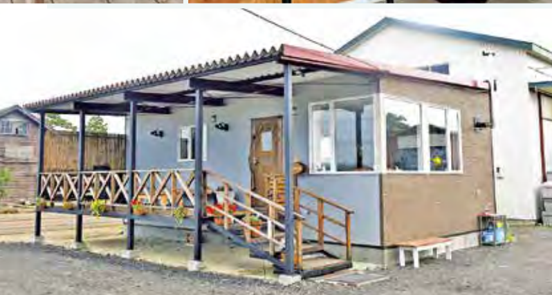
カフェの外観。内装や階段、扉なども稔さんの手作り
