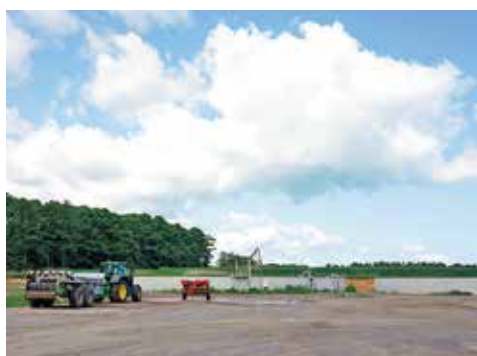
バイオマスプラント
